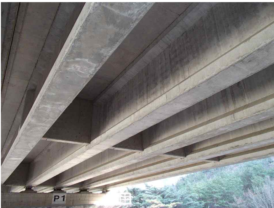
PSC I BEAM 전경
