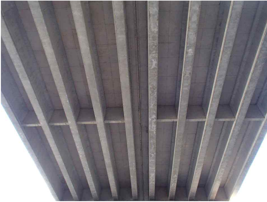
바닥판하면 및 PSC I BEAM 전경
