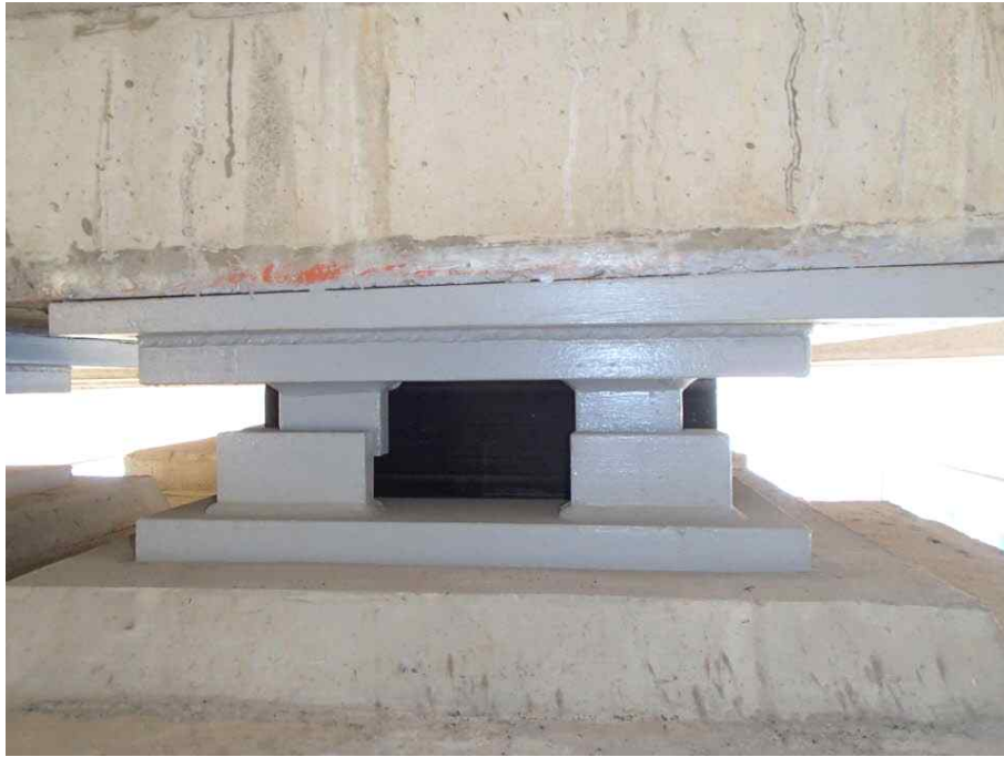
받침장치 전경 (고정단)
